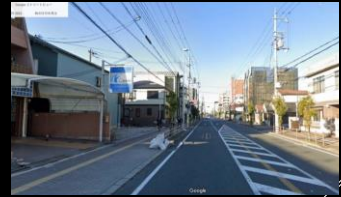
阪奈下り線 栄和町 中井保険事務所 前
